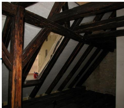
oprava střešní konstrukce krov
