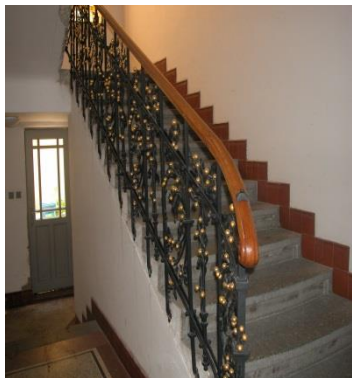
restaurování schodů a zábradlí
