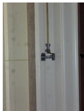
detail zrepasovaného táhla u okna
