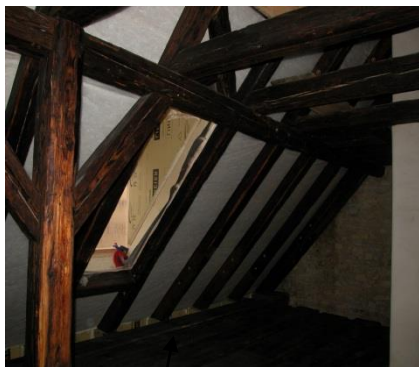
oprava střešní konstrukce - krov
