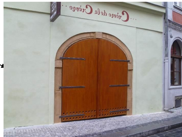
detail restaurování vstupních vrat – kovářské práce
