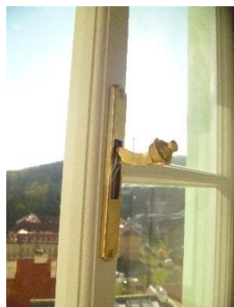
detail zrepasované kličky u okna a dveří
