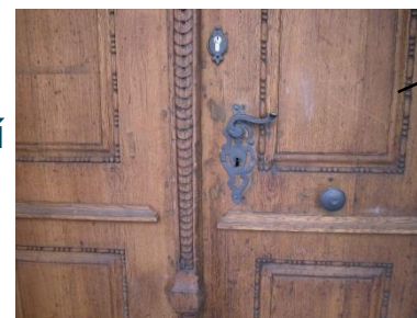
restaurování vstupních vrat
