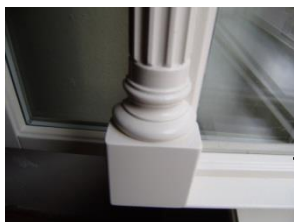
detail vyměněné zdobné části okna
