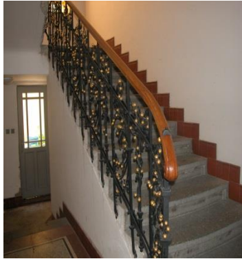
restaurování schodů a zábradlí
