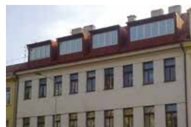
zcela nevhodná velikost vikýřů – PZ
