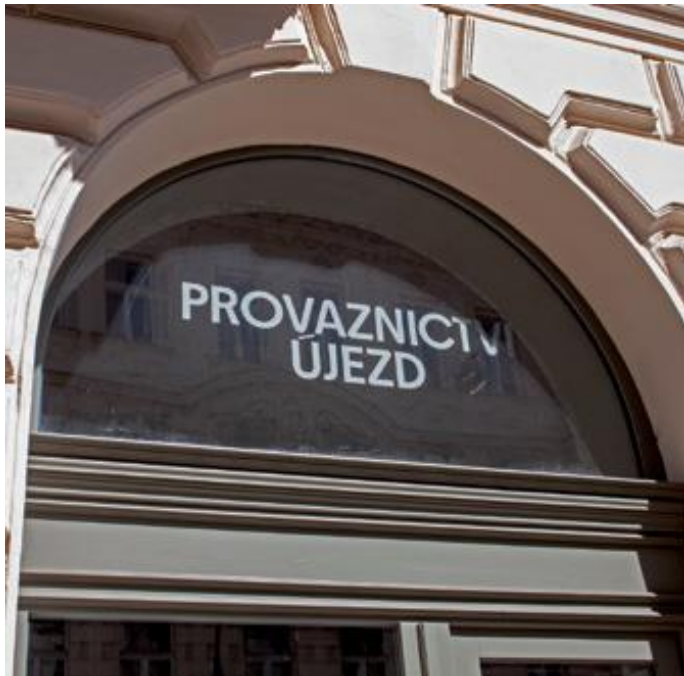
Polep zhotovený tak, aby evokoval pískování skla.
