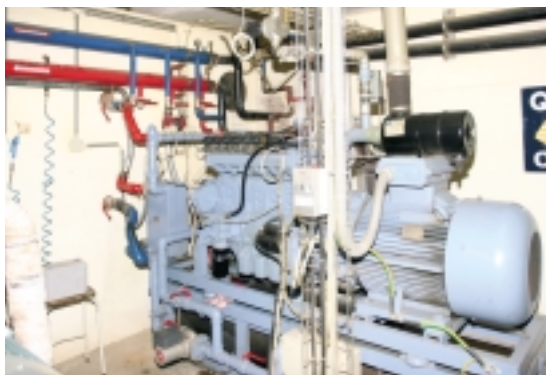
Základem mnoha kogeneračních jednotek je upravený motor z automobilu, na snímku bez protihlukového krytu.
