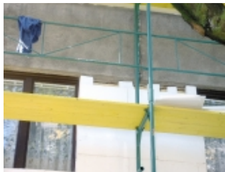
Ponechání původní MIV a vyrovnání rozdílné tloušťky izolací a vzduchovou mezerou.
