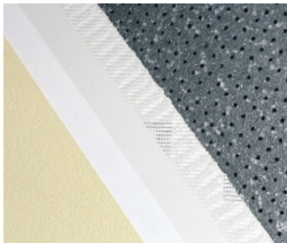
Zateplení polystyrenem s malým difúzním odporem.
