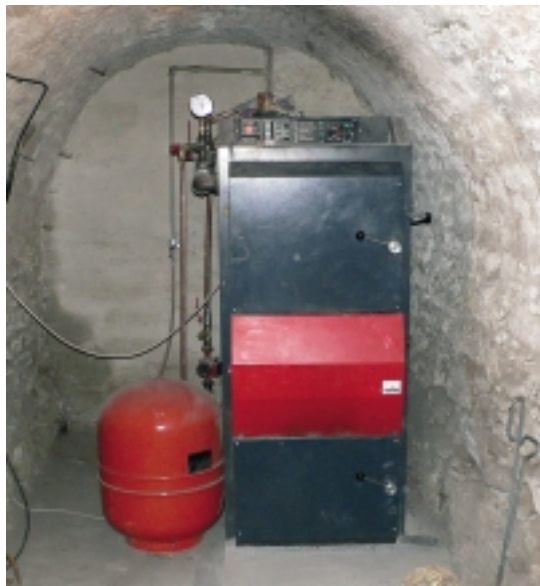
Kotel na kusové dřevo bez akumulací nádrže není ideální.
