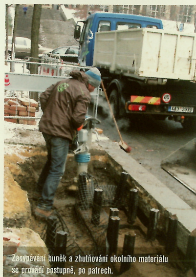
Prostor kolem buněk se zasypává původní odebranou zemínou smíchanou s kamenivem.
