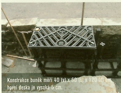
Místo pro plastové buňky je někde tak omezené, že se konstrukce ukládají jen podélně.
