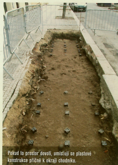
Zasypávání buněk a zhuňování okolního materiálu se provádí postupně, po patrech.
