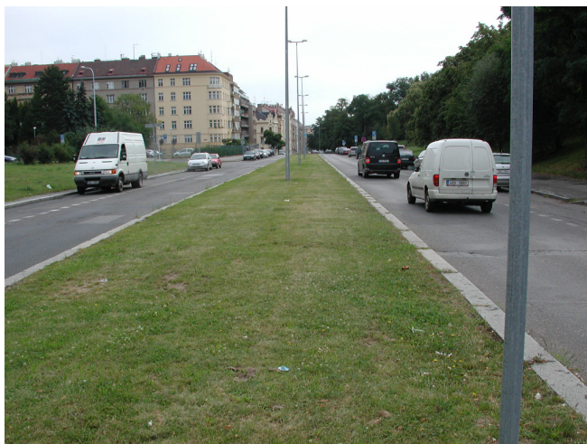
Stav před realizací. Srpen 2009.
