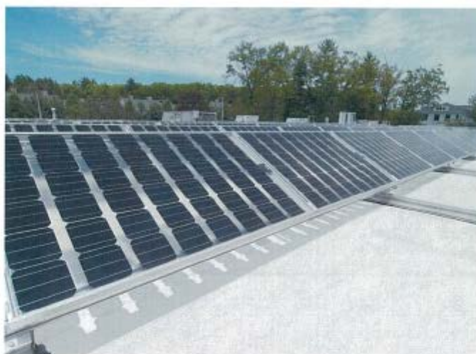
Obr. 2 Bifaciální panely na bílé střeše
