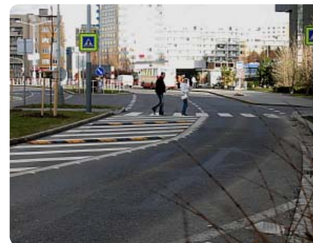
Opticko-akustické brzdy a příčné prahy, zúžení vozovky v místě přechodu přes Olbrachtovu ul., Praha 4 – ZŠ Poláčkova (projekt Bezpečné cesty do školy, Pražské matky ve spolupráci s MHMP, 2004, realizace 2004)
