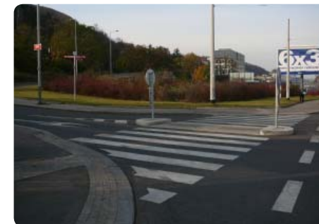
Dělicí ostrůvek přes ul. Křížová, Praha 5 – Zlíchov – Speciální ZŠ pro žáky se specifickými poruchami chování (projekt Bezpečné cesty do školy, Pražské matky a Oživení ve spolupráci s MHMP, 2007, realizace 2008)
