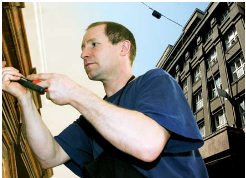
RESTAURÁTORSKÉ PRÁCE tvoří nejnáročnější část celkové rekonstrukce nového sídla pražského magistrátu.
