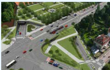
Křižovatka Prašný most, vjezd z Brusnického tunelu
