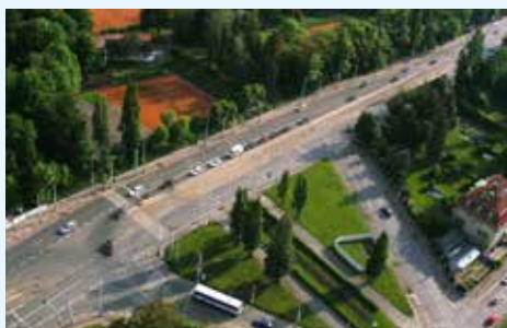
Prašný most před rekonstrukcí
