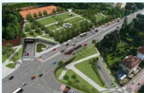
Prašný most po rekonstrukci
