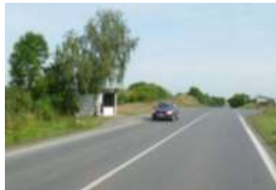
➤ Zastávka bez nástupní hrany a s absencí přístupové pěší vazby [Kojetice, rozc.].
