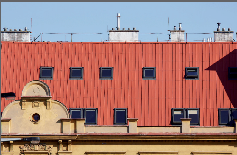
Původní keramická krytina nahrazena krytinou plechovou
