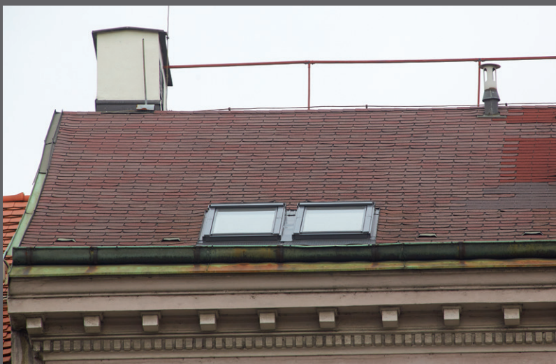
Původní keramická krytina nahrazena střešním asfaltovým šindelem
