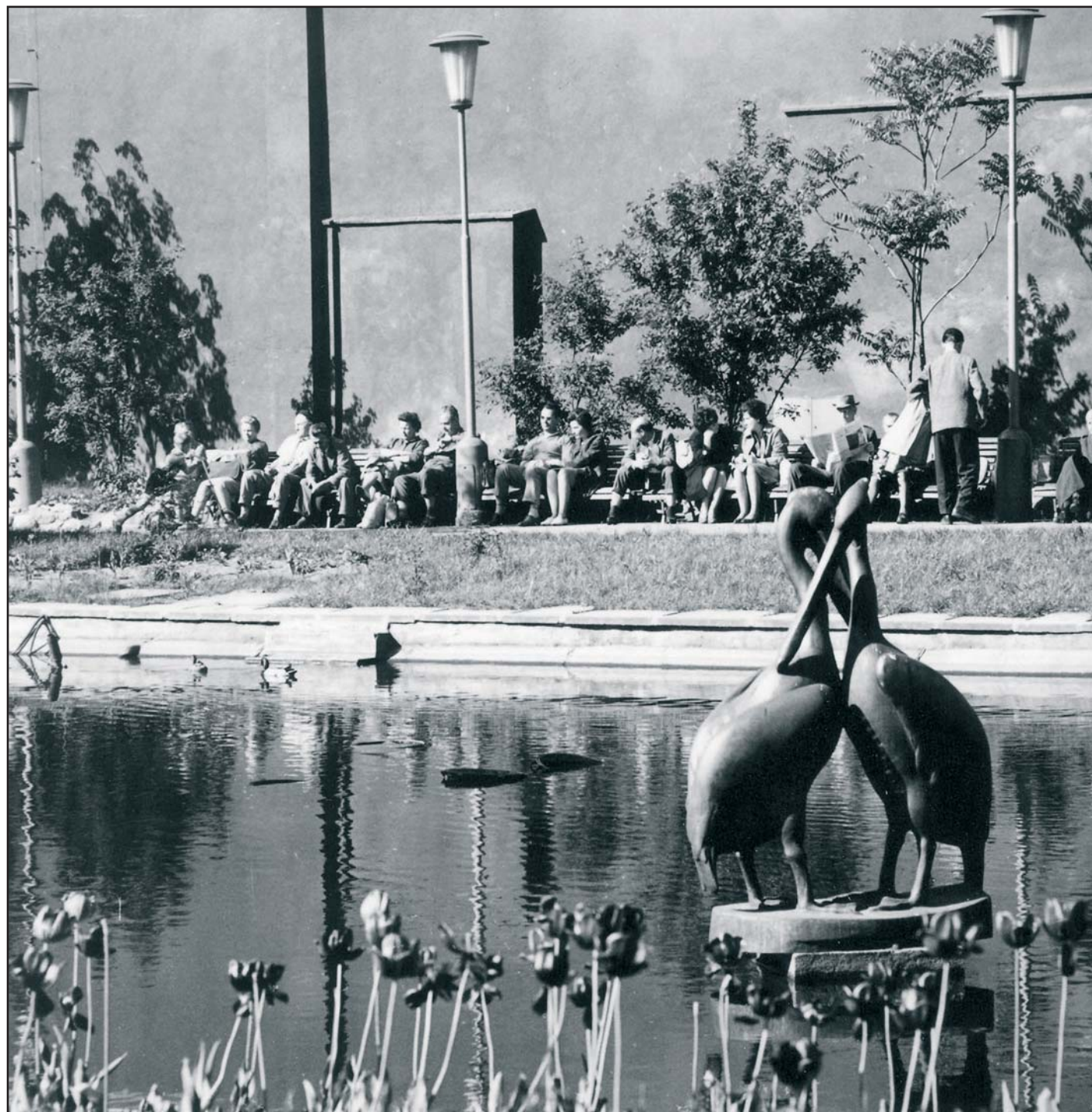
Ulice Na Příkopě, okraj Starého Města, Praha 1. Novostavba paláce Myslbek vyplnila proluku, vzniklou po demolici výstavního pavilonu uměleckého spolku Myslbek v 50. letech 20. století. Proluka, sloužící jako park, spojovala Příkopy s Ovocným trhem. Na Příkopě Street, Old Town side, Prague 1. The recent Myslbek Building filled the gap left by the demolition of the exhibition hall of the Myslbek Arts Association in the 1950s. The open space was turned into a park that linked Na Příkopě with the Fruit Market.
