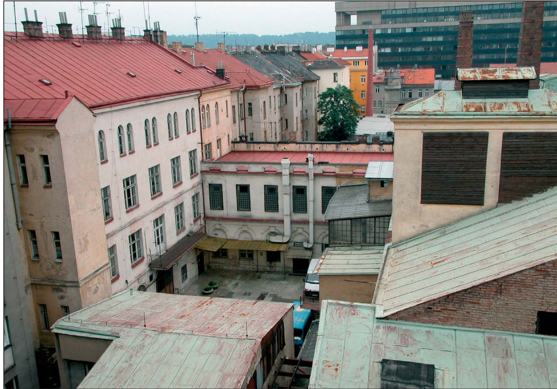
Osadní ulice, Holešovice, Praha 7. Rekonstrukcí a dostavbou bývalé továrny na výrobu uzenin a pražské šunky vzniká polyfunkční objekt s restauracemi, obchody, ateliéry, byty a garážemi ( – Studio Olgoj Chorchoj). Osadní Street, Holešovice, Prague 7. The reconstruction of a former smoked-meats and Prague-ham factory to create a multifunctional complex with restaurants, shops, studios, flats and garages (Olgoj Chorchoj Studio).
