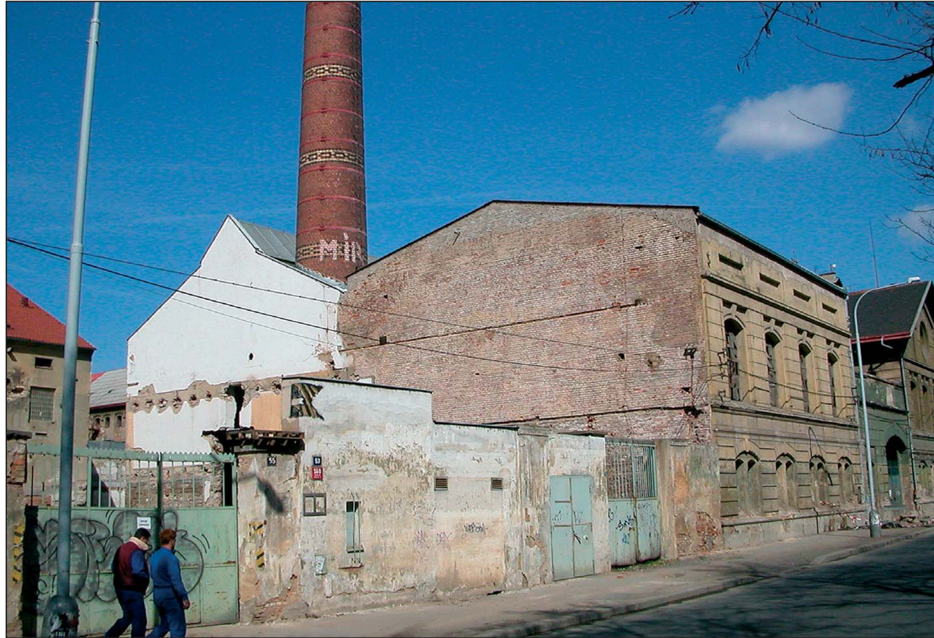
Pernerova ulice, Karlín, Praha 8. Administrativní budova „Kotelna“, jejíž název naznačuje původní využití rekonstruovaného průmyslového objektu z 19. století (Claudio Silvestrin Architects, Londýn, architekti C. Silvestrin, L. Parilli, O. Kamphoff, AED Project, Praha). Perner Street, Karlín, Prague 8. The “Kotelna” (boiler house) office block, whose name commemorates the original use of this converted 19th-century industrial building (Claudio Silvestrin Architects, London, architects C. Silvestrin, L. Parilli, O. Kamphoff, AED Project, Prague).
