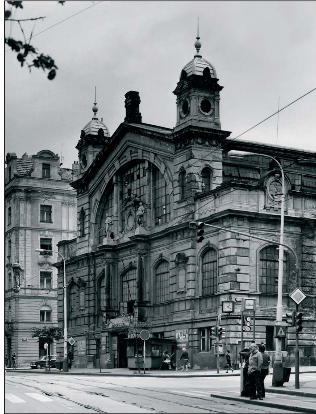
Vinohradská třída, Vinohrady, Praha 2. Vinohradské tržiště hrozila po požáru v roce 1986 demolice, díky zdařilé rekonstrukci byl historický objekt zachráněn. Vinohrady Avenue, Vinohrady, Prague 2. The Vinohrady Market was under threat of demolition in 1986 after a fire, but the historical building was saved thanks to a successful reconstruction.
