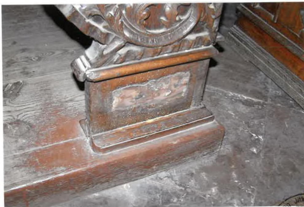
foto č. 3- chybějící řezba na boku lavice, červotoč
