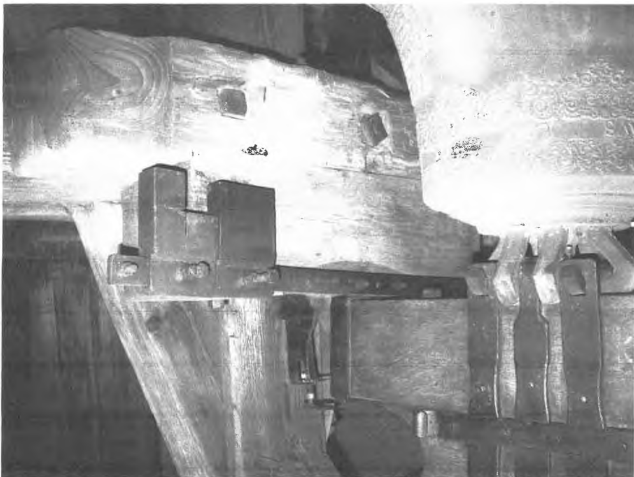
2./Protizávaží na závěsu zvonu před opravou
