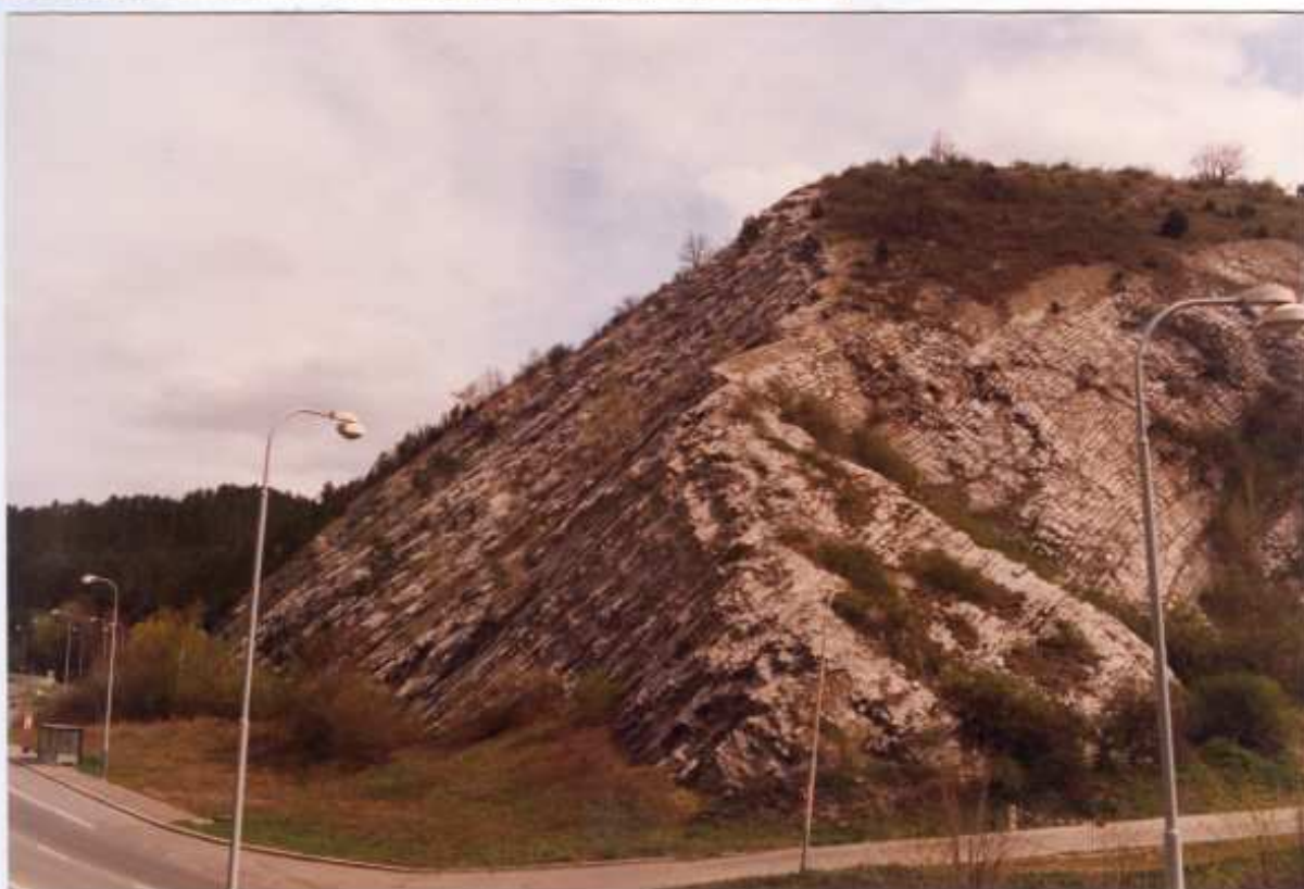
Celkový pohled na lomovou stěnu (parcela 2961/4 Radotín) a skalní step nad ní
