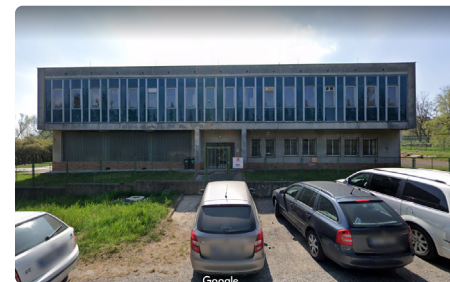
stávající budova na TVV
