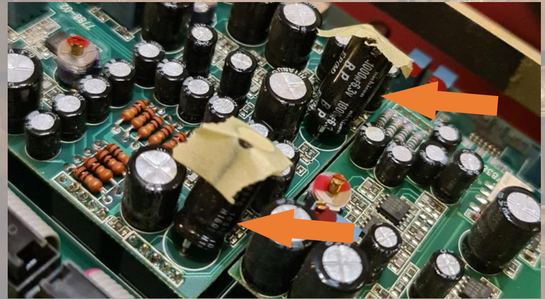
oprava pomocí dostupných komponentů s odlišným rozměrem
